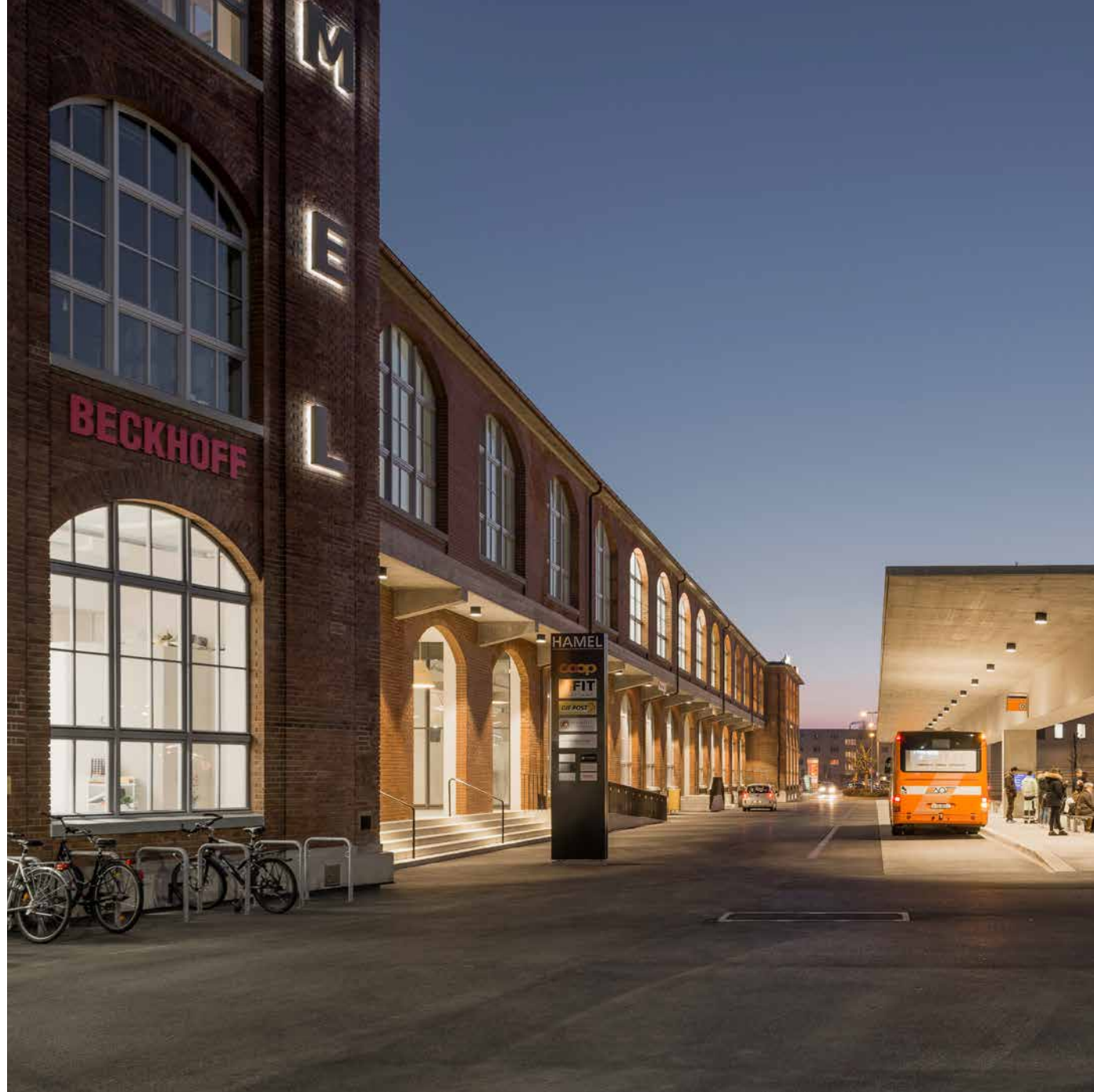
Edificio Hamel Saurer WerkZwei, Arbon
